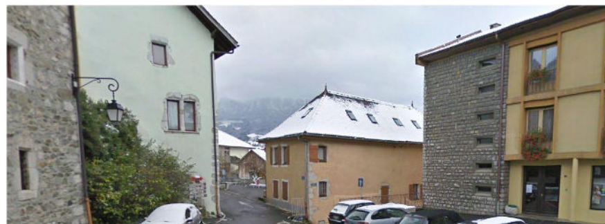
Rue de l'hôpital: Coexistence de traitements de façade divergents
