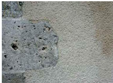
Enduit à pierre vue
