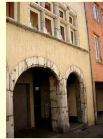
XVI ème : façade enduite en totalité sauf les encadrements en pierre de taille : la limite pierre/enduit est régulière : elle ne suit pas la forme de chaque pierre.
