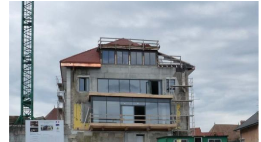
Démolition partielle-reconstruction: La médiathèque en chantier
