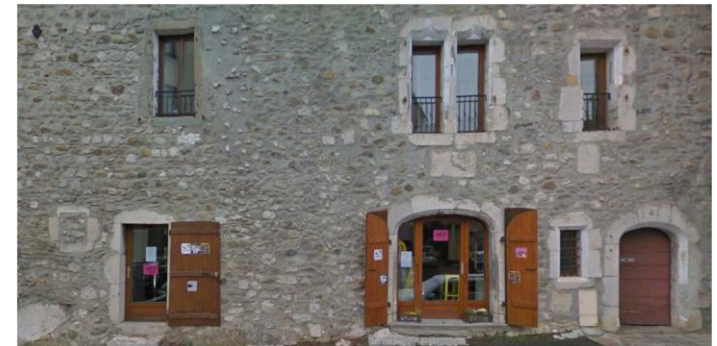
Dégarnissage « en pierres apparentes » peu adapté au contexte local
