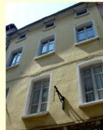
XVI ème : façade enduite en totalité. Les encadrements sont badigeonnés d'une teinte plus claire avec un retour en tableau.
