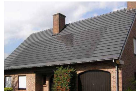
Tuiles photovoltaïques
