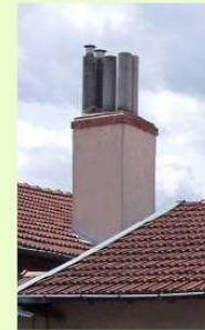
Souche maçonnerie et enduite
