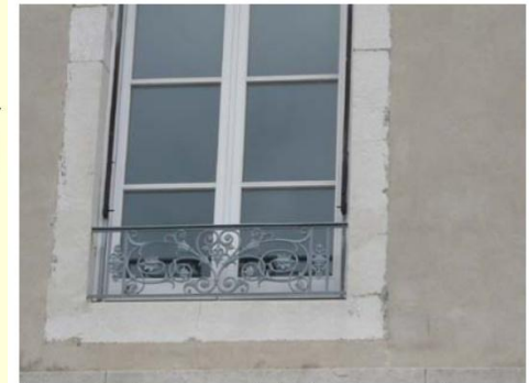
XVI ème : façade enduite en totalité sauf les encadrements en pierre de taille : la limite pierre/enduit est régulière : elle ne suit pas la forme de chaque pierre.
