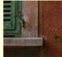
Enduit venant buter sur l'encadrement en pierre en saillie.
