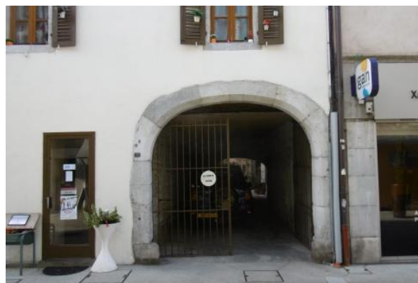
Entrée cour rue du Silence
