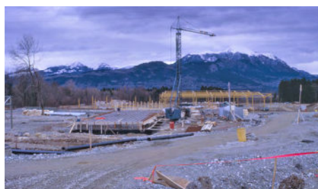
Construction du hall des expositions, février 1970, Archives municipales de La Roche-sur-Foron, 27Fi67, Fonds Jean MORIN (don de Roger DURET).
