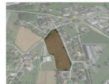
Vue satellite du site
