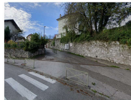
Terrain en surplomb sur la rue du Buisson
